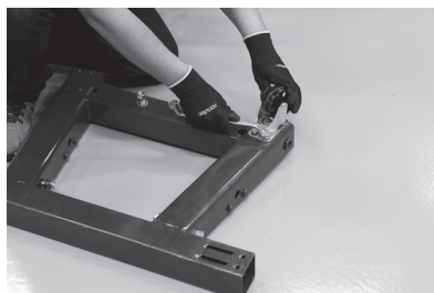
Figura 4 – Montaje de las ruedas en la base del guinche
